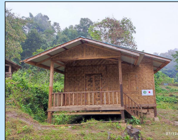
ချီဖွေမြို့နယ်၊ ဂျိတ်လွယ်ကျေးရွာတွင် နေအိမ်များ တည်ဆောက်ခြင်း
