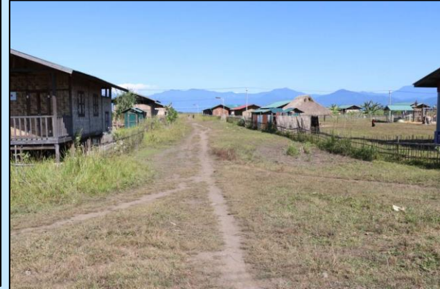
ပူတာအိုမြို့နယ်၊ ဇီဒမ်း (၂) ကျေးရွာတွင် နေအိမ်များ တည်ဆောက်ခြင်း
