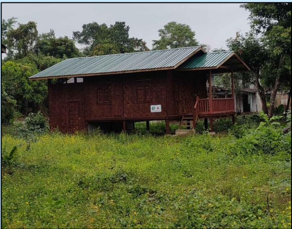
ဝိုင်းမော်မြို့နယ်၊ ဂါးရာယန်ကျေးရွာတွင် နေအိမ်များ တည်ဆောက်ခြင်း
