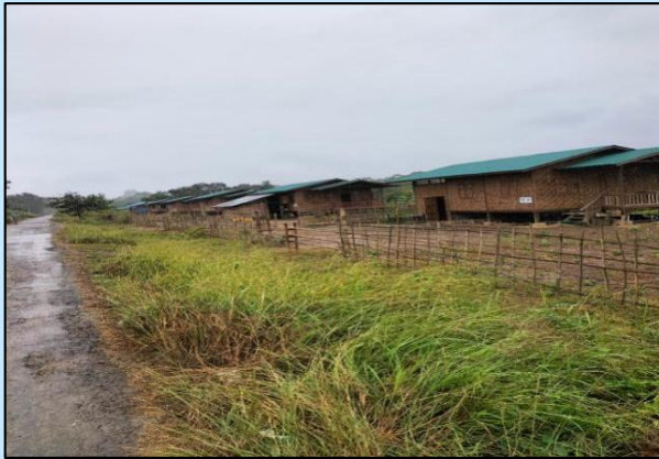
မြစ်ကြီးနားမြို့နယ်၊ ရေကြည်ကျေးရွာတွင် နေအိမ်များ တည်ဆောက်ခြင်း
