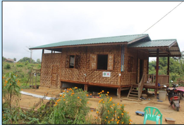
မန်စီမြို့နယ်၊ ဂါရာယန်ကျေးရွာတွင် နေအိမ်များ တည်ဆောက်ခြင်း
