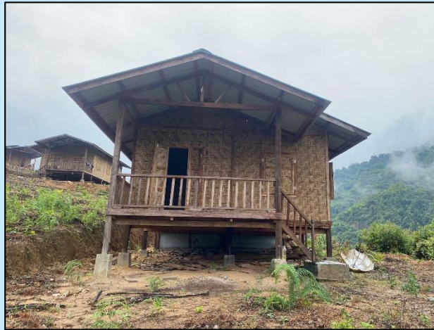
ချီဖွေမြို့နယ်၊ ရစ်ကျော်ကျေးရွာတွင် နေအိမ်များ တည်ဆောက်ခြင်း
